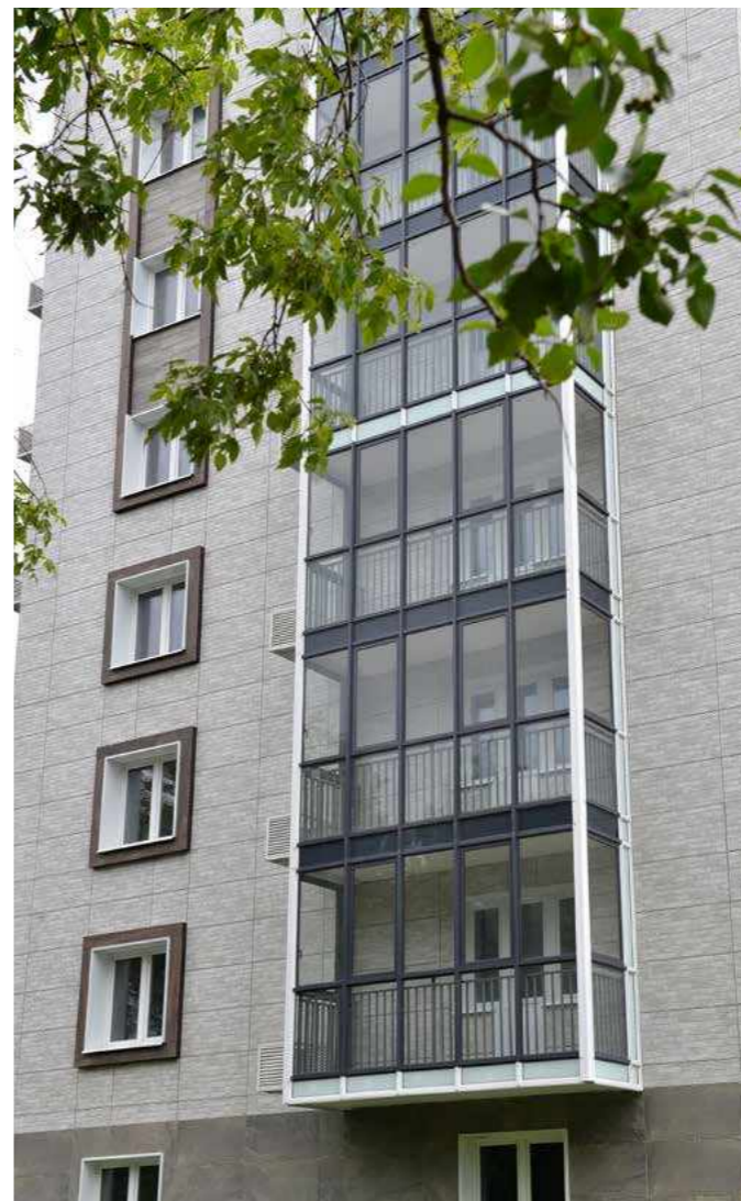
Москва, ЖК "Дом в 1-м Тушинском проезде" / Moscow, «Dom v 1-m Tushinskom proезде» URBAN BRICKS
